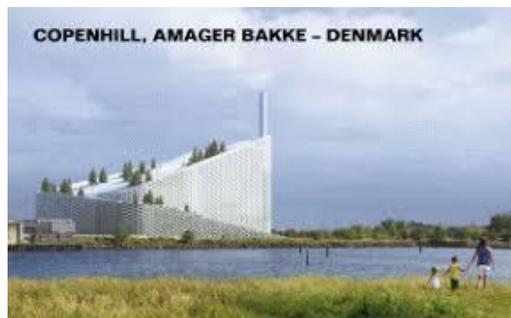
Un termovalorizzatore con emissioni minime e che con la combustione dei rifiuti fornisce elettricità a 62 mila persone e ne riscalda 160 mila, costruito in città, all'interno di un parco, sulle cui pareti si può fare una arrampicata e con un tetto in discesa sul quale si può sciare tra gli alberi. E' il termovalorizzatore di Copenhagen (Danimarca), chiamato Copenhill, cioè collina di Copenhagen.
